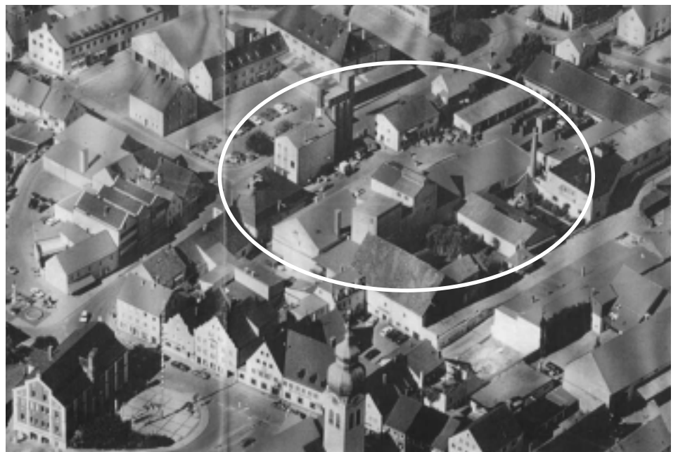
Da wird es hinkommen, das Deutsche Hopfenmuseum. Links unten zu erkennen: Das Wolnzacher Rathaus und die Pfarrkirche, oben in der Mitte entsteht demnächst ein großes Einkaufszentrum.
