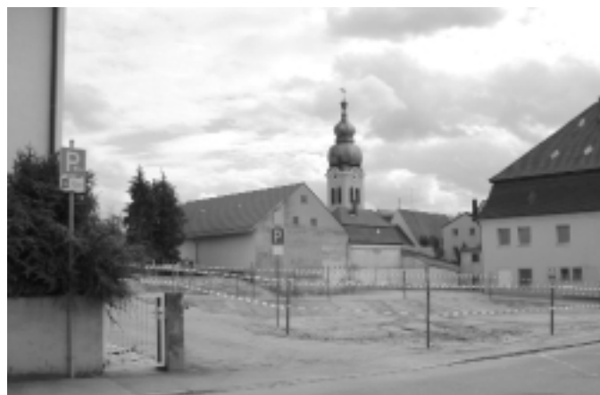
Die alten Brauereigebäude auf dem Spatengelände im Zentrum von Wolnzach sind abgebrochen, nun kann neu gebaut werden.
